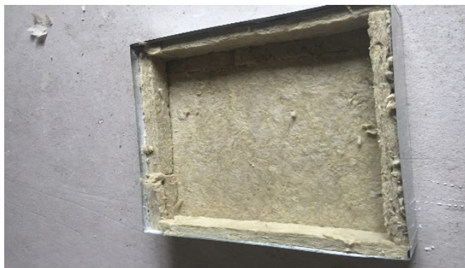
Рис. 4. На дно корпуса укладываем базальтовую теплоизоляцию 50 мм
