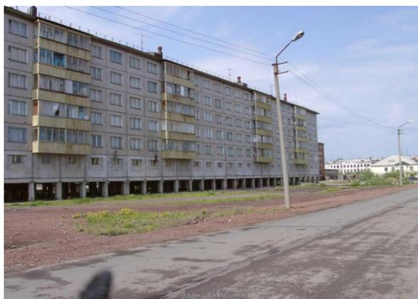
Рис. 1. Многоэтажные дома на вечной мерзлоте
