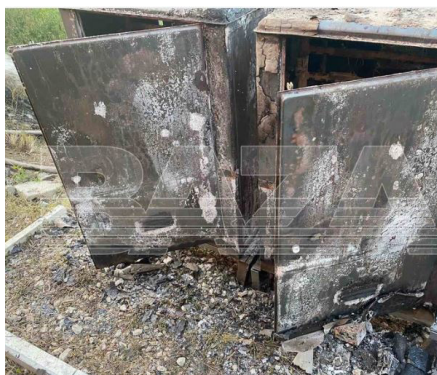
Рис. 1. Последствия поджога релейного шкафа
