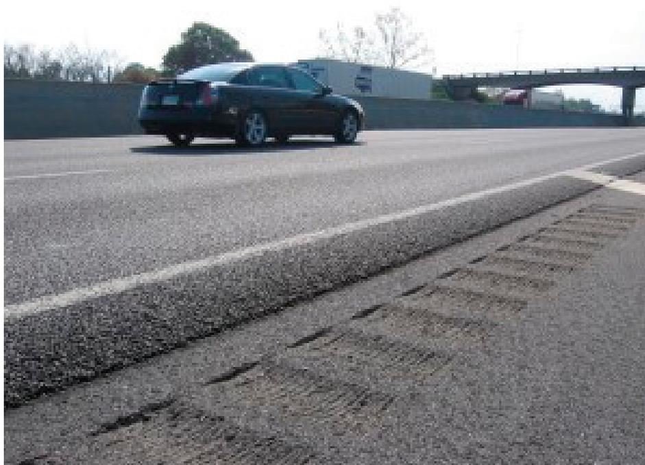
Рис. 1. Фрезерованная шумовая полоса
