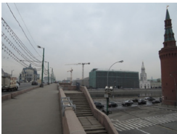
Рис. 4. Строительная площадка рядом с Большим Москворецким мостом
