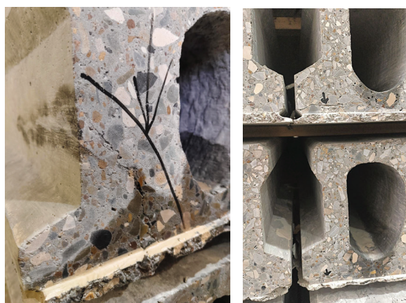
Рис. 2. Вариации продольных трещин по «юбкам» плит перекрытий
