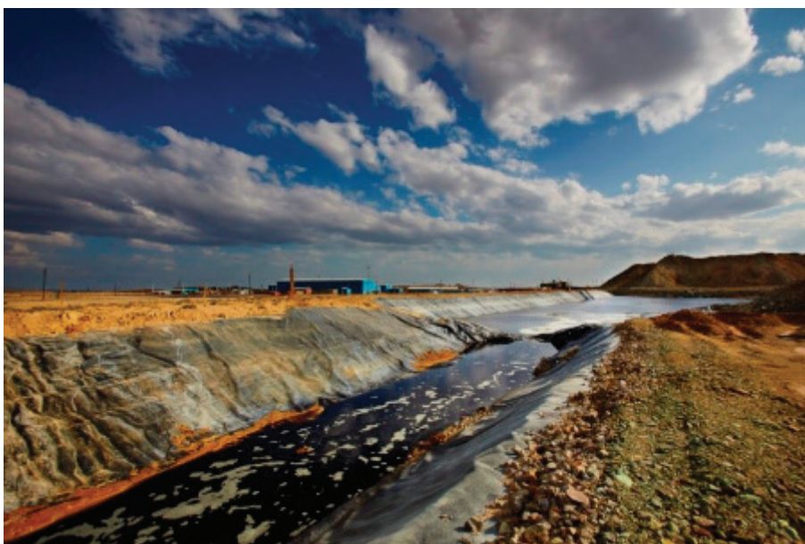
Рис. 2. Система сбора продуктивного раствора и циркуляции
