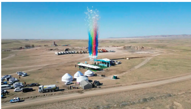
Рис. 2. Строительство Горно-обогатительного комбината в Кордайском районе
