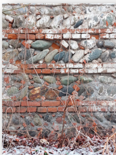
Рис. 1. Владикавказская каменная кладка с добавлением кирпича
