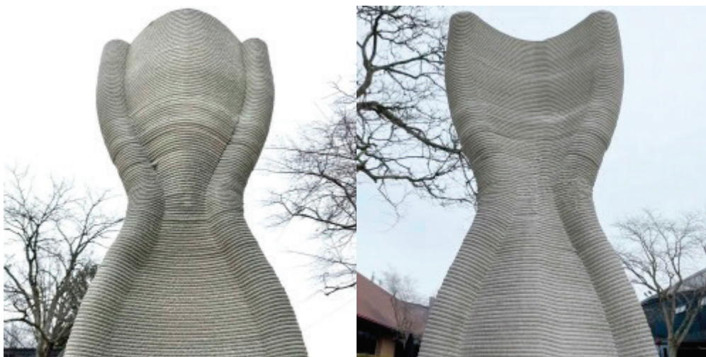
Рис. 4. Shell Wall (вид спереди и сзади подчеркивает уменьшение расхода материала, достигнутое за счет тонкой мембраны между структурными ребрами в высокой, дважды изогнутой стене) [ https://www.forma.spb.ru/archiblog/2023/04/04/sverhlyogkaya-beton-dlya-3d-pechati/?ysclid=m6rpkiw1id912196171 ]
