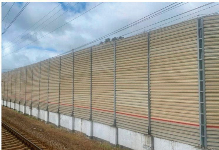
Рис. 3. Шумоотражающие экраны в Колпинском районе
