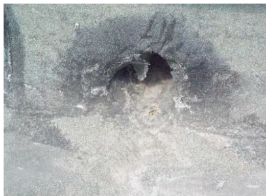
Рис. 5. Повреждение гидроизоляционного ковра в местах водоприемных труб
