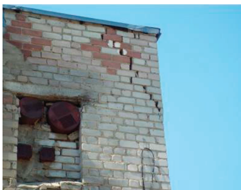
Рис. 3. Наклонные, сквозные трещины в кирпичном парапете здания
