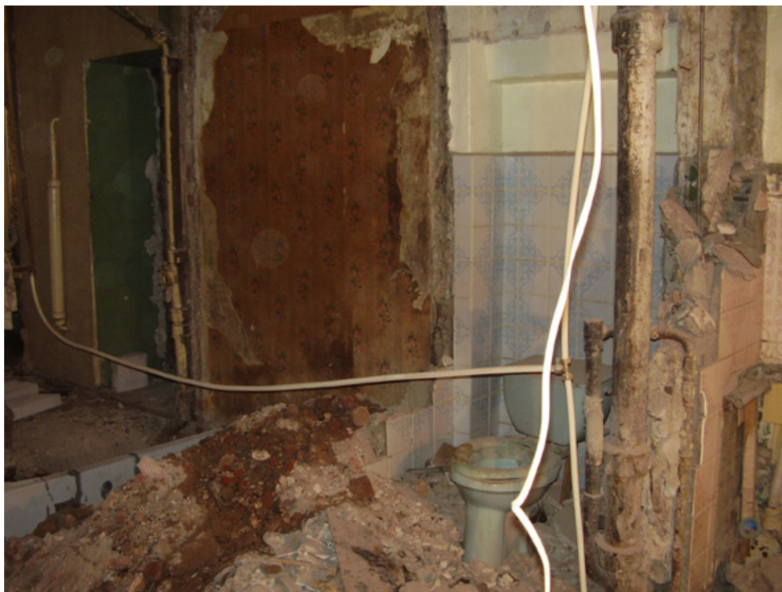
Рис. 1. Реконструкция квартиры на первом этаже старого дома под офис. Мусор попадает в унитаз, которым пользуются строители. Впоследствии имели место засоры канализации и затопления расположенных выше квартир
