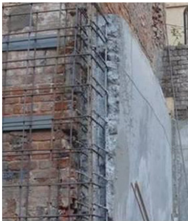
Рис. 2. Усиление каменной стены железобетонной обоймой
