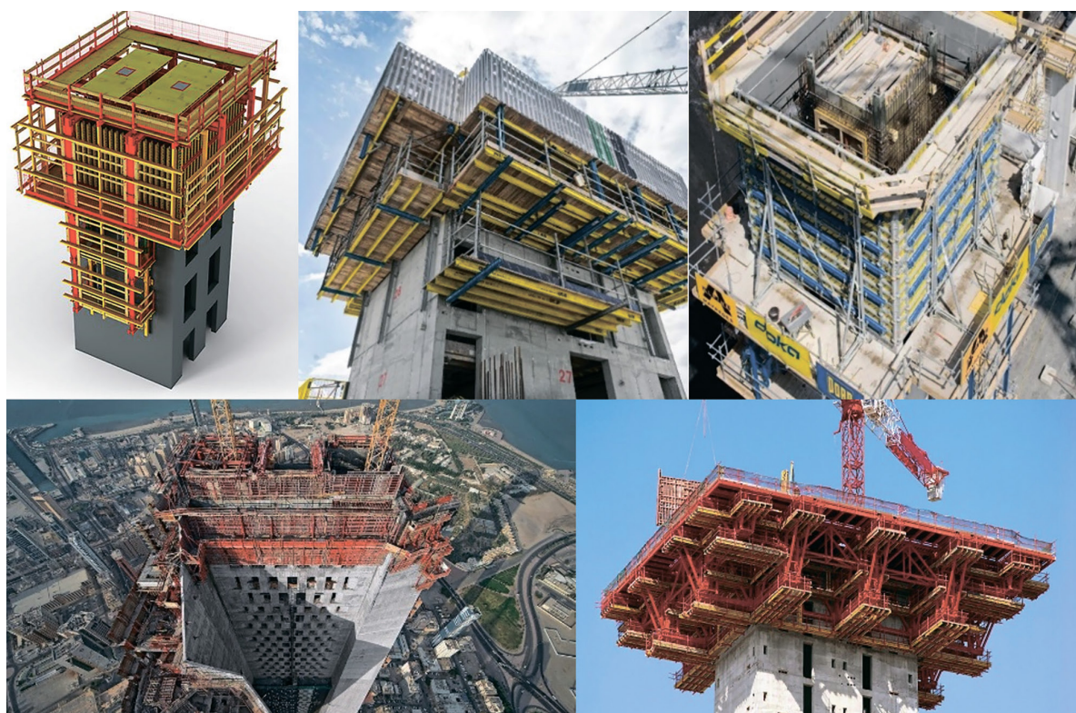
Рис. 4. Платформы для самоподъемной опалубки
