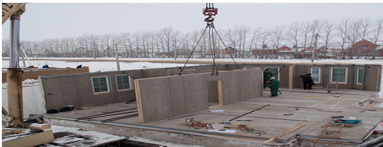
Рис. 2. Монтаж панелей изготовленные компанией «ТАМАК»
