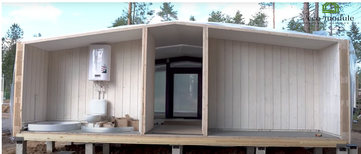
Рис. 3. Установленный модуль здания компании «ПРОМСТРОЙЛЕС»
