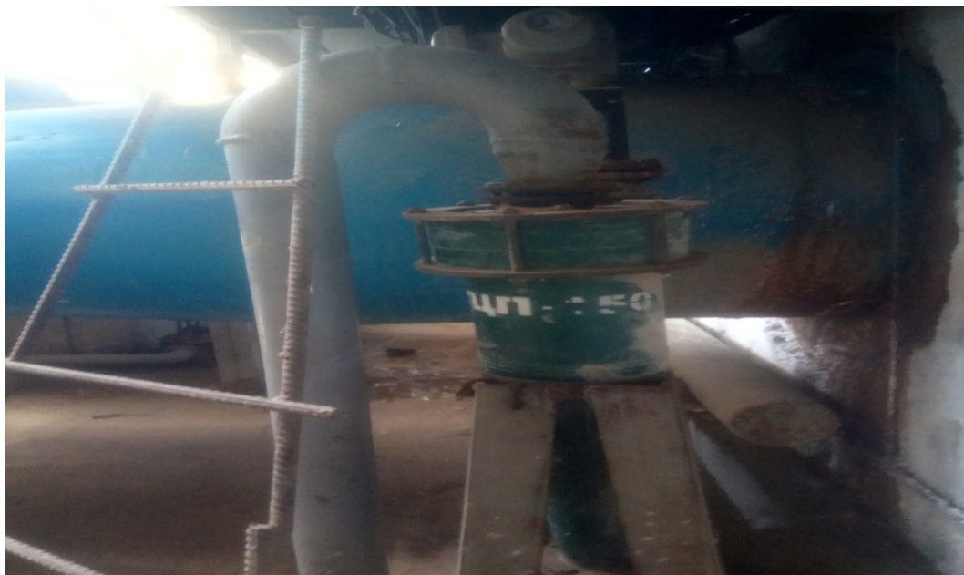
Rasm 2. GSP-150 markali gidrosiklon
