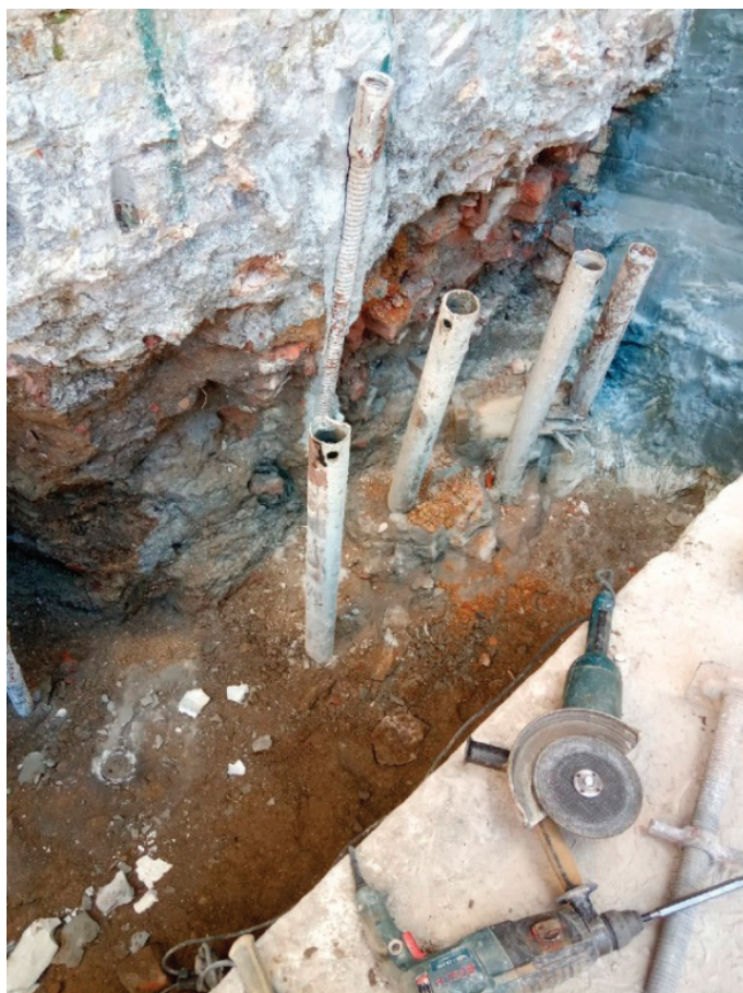
Рис. 5. Усиление подземной части исторического здания в центральном районе Санкт-Петербурга технологией jet grouting
