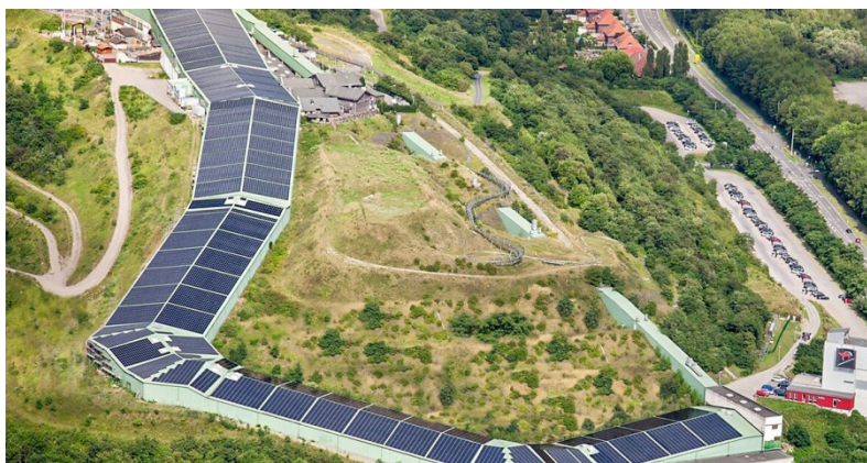
Рис. 1. Крытый горнолыжный комплекс «Alpincenter Bottrop» в г. Ботроп
