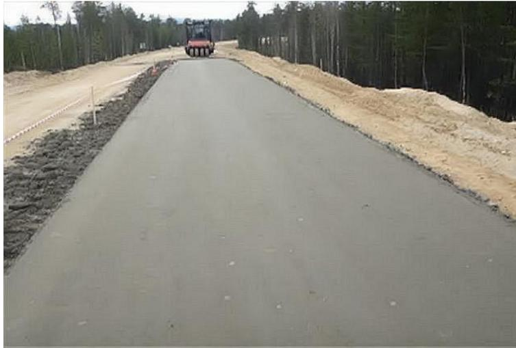
Рис. 4. Строительство дорожного покрытия из армированного грунта на нефтепромысловой дороге в Мурманской области К-В-ПП «Лотта»
