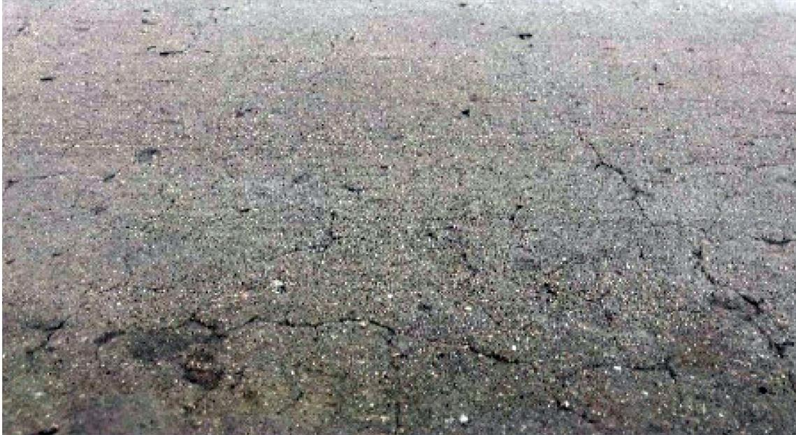
Рис. 2. Мелкие волосяные усадочные трещины
