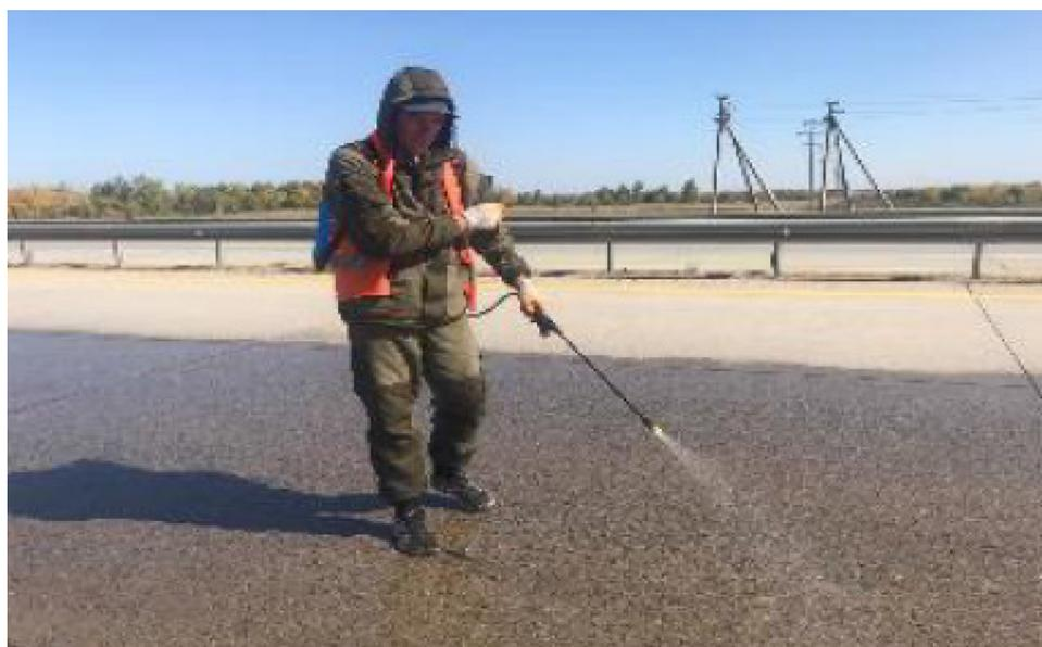
Рис. 5. Нанесение состава ручным способом
