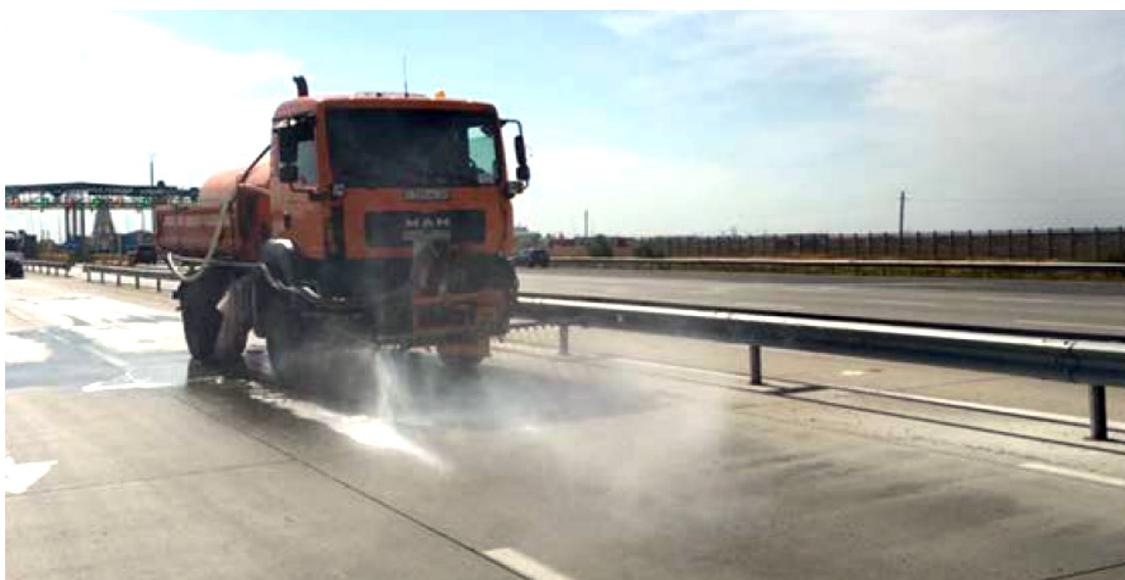
Рис. 4. Нанесение состава водовозом с распределительной рампой
