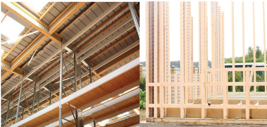
Рис. 3. Применение двутавровых HTS-балок в строительстве
