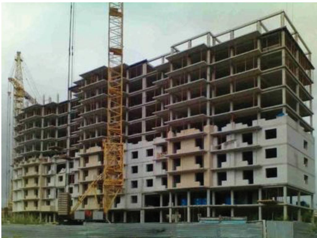
Рис. 1. Возведение здания по сборно-монолитной технологии
