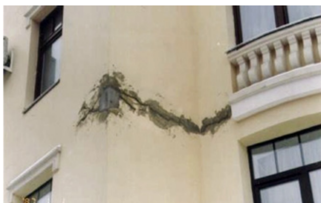
Рис. 3. Горизонтальные трещины в штукатурке по сетке в уровне горизонтального деформационного шва
