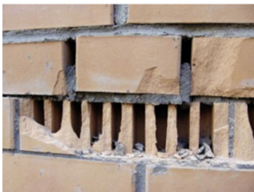
Рис. 1. Разрушение кирпичей лицевого слоя наружной трехслойной стены в уровне перекрытия
