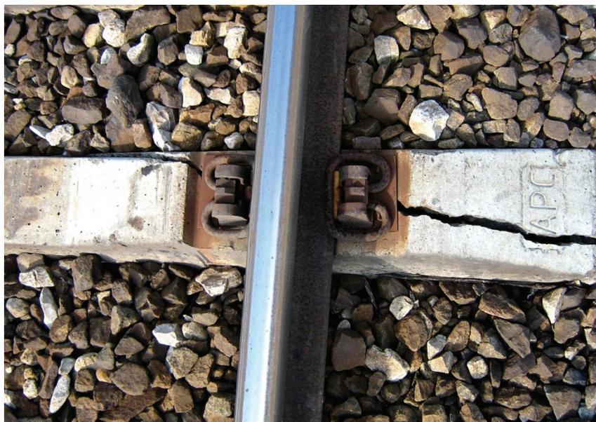
Рис. 2. Треснувшая железобетонная шпала
