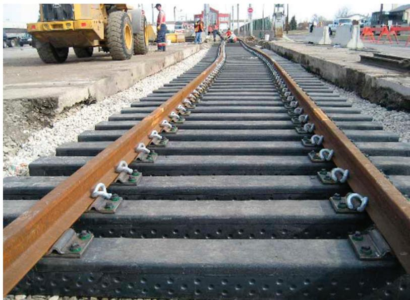
Рис. 3. Путь, уложенный на полимерных шпалах
