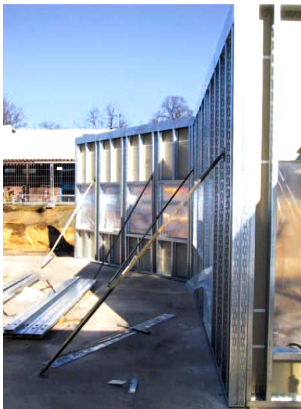
Рис. 1. Полнообъемные фасадные элементы в процессе строительства
