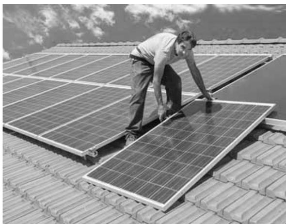
Рис. 2. Монтаж монокристаллических батарей
