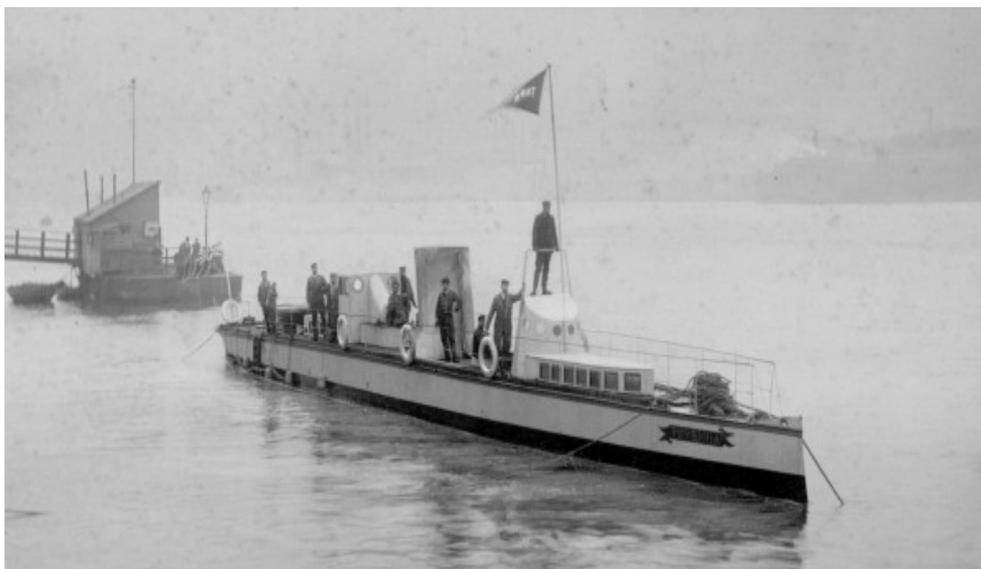
Рис. 1. «Турбиния» Чарльза Парсонса — первое в мире судно с паровой турбиной
