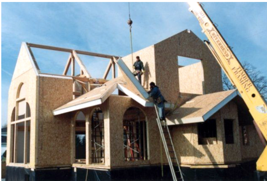
Рис. 2. Общий вид монтажа SIP-панелей
