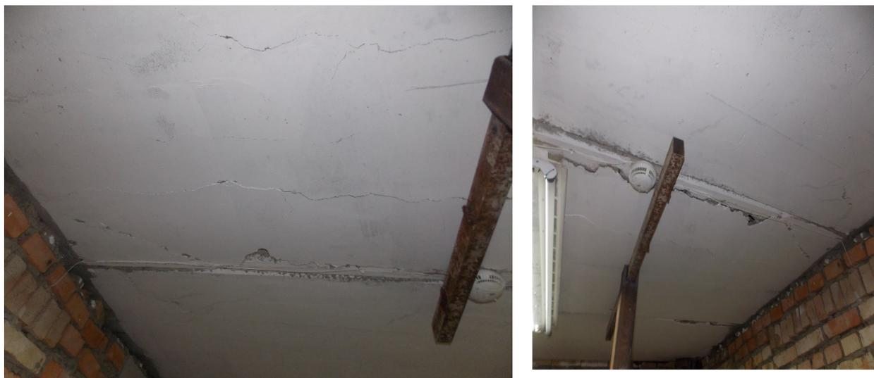
Рис. 7. Развитие трещин в растянутой зоне плит перекрытия
