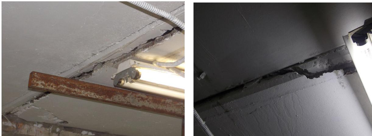
Рис. 5. Разрыв нижней растянутой зоны бетона в зоне армирования
