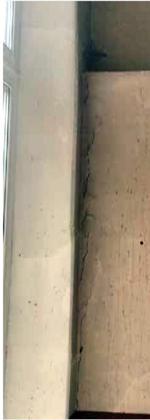
Рис. 5. Поперечные трещины в штукатурке стены
