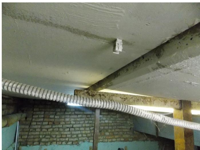
Рис. 4. Средняя железобетонная плита имеет деформации превышающие предельно допустимое значение по СП
