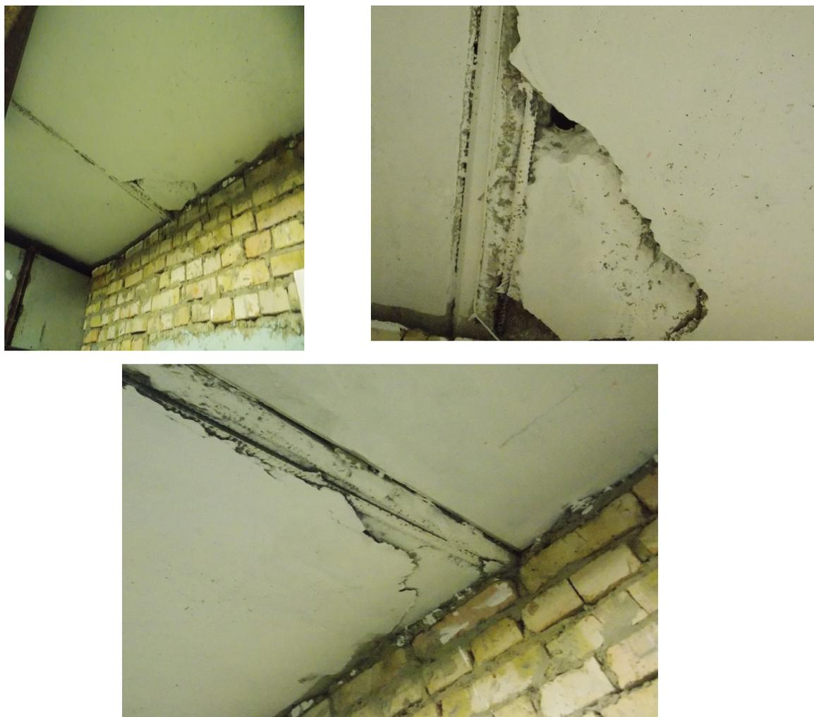
Рис. 6. Разрушение бетона в опорной части плит покрытия
