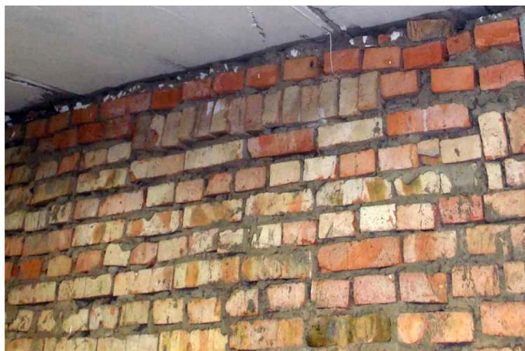
Рис. 2. Выпадение и разрушение отдельных кирпичей в опорной части плиты
