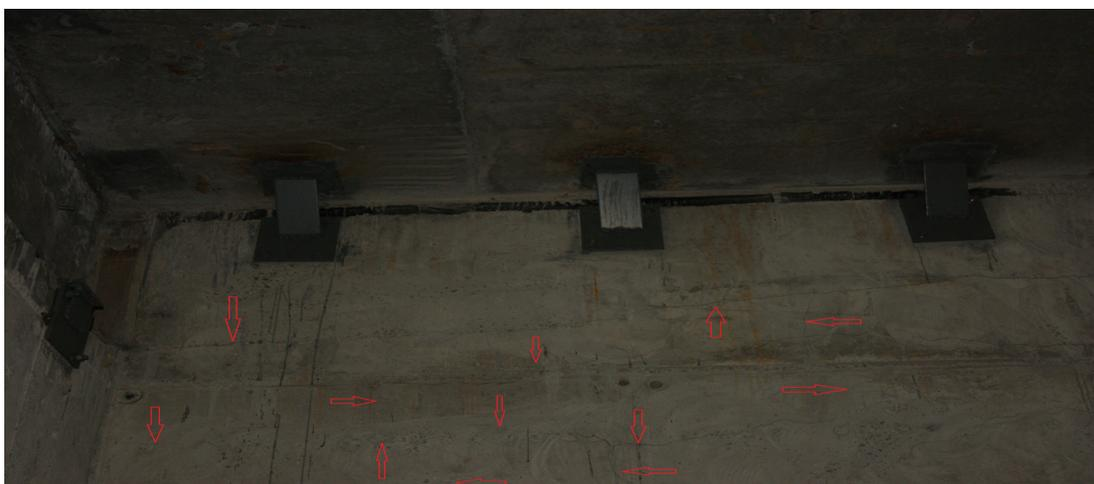
Рис. 4. Усадочные трещины с развитием в различных направлениях
