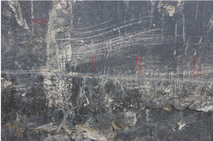
Рис. 2. Продольные и поперечные трещины в бетонной стене со стороны улицы
