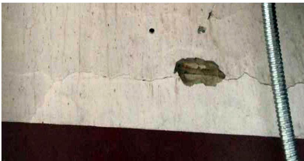
Рис. 4. Продольные трещины в штукатурке стены
