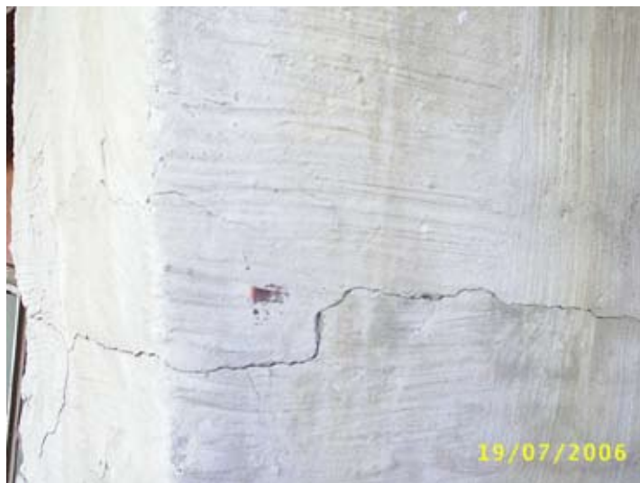
Рис. 1. Пример трещины в бетонной колонне
