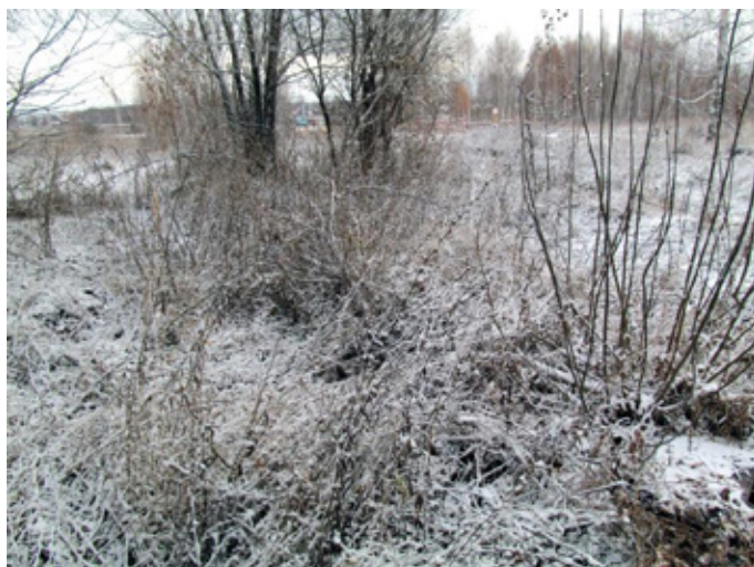
Рис. 1. Не расчищена трасса подземного газопровода от поросли кустарников
